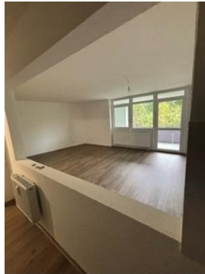
Bilder nach Sanierung
