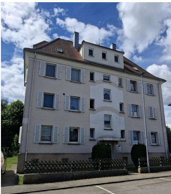
Mittelstadtstraße 4 in Rottweil
