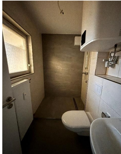
Bilder nach Sanierung
