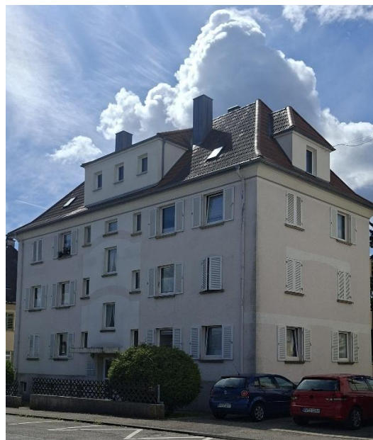
Mittelstadtstraße 6 in Rottweil
